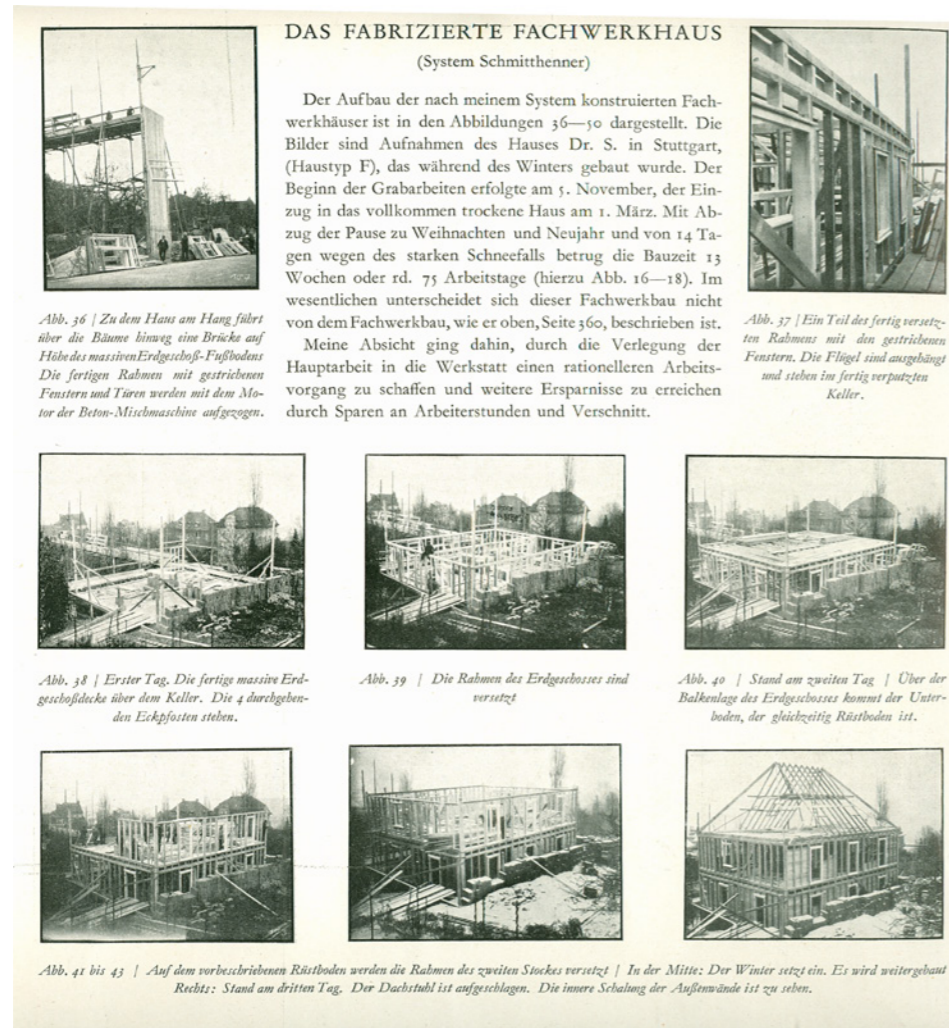
8 Paul Schmitthenners „Fabriziertes Fachwerk“ oder „Fafa“. Musterbaustelle eines Wohnhauses in Stuttgart, Winter 1927/28. Dokumentation der Baustelle vom ersten bis zum dritten Tag in Wasmuths Monatsheften für Baukunst, 1929
