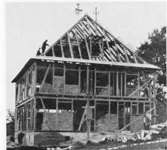
Das Baugerippe unterscheidet sich nicht wesentlich von der alten Fachwerkbauweise
