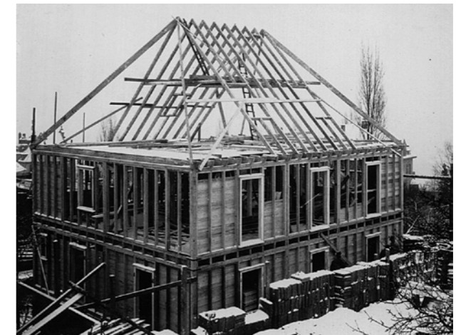
9 Fafa-Wohnhaus in Stuttgart, Baustelle am dritten Tag
